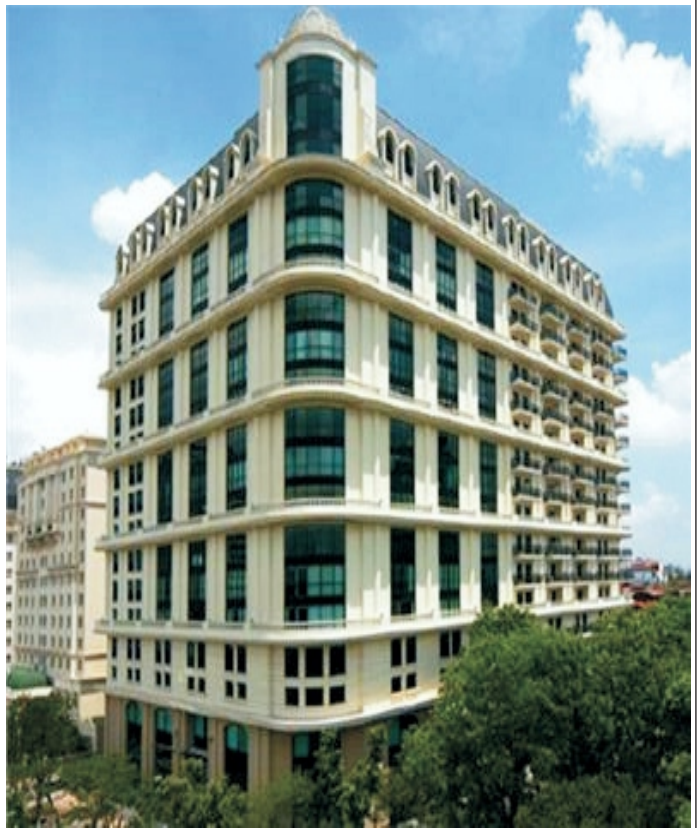
TÒA NHÀ PACIFIC LÝ THƯỜNG KIỆT, HÀ NỘI THI CÔNG ĐIỀU HÒA
