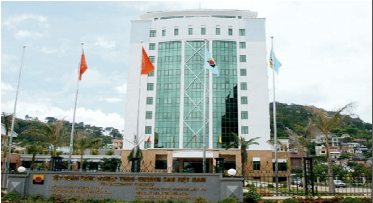
TÒA NHÀ VĂN PHÒNG LIÊN CƠ QUAN TKV QUẢNG NINH HẠ LONG, QUẢNG NINH THI CÔNG ĐIỀU HÒA VÀ THÔNG GIÓ
